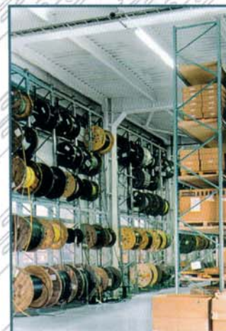
Regály na káblové cievky a palietovú skladovacej hale
